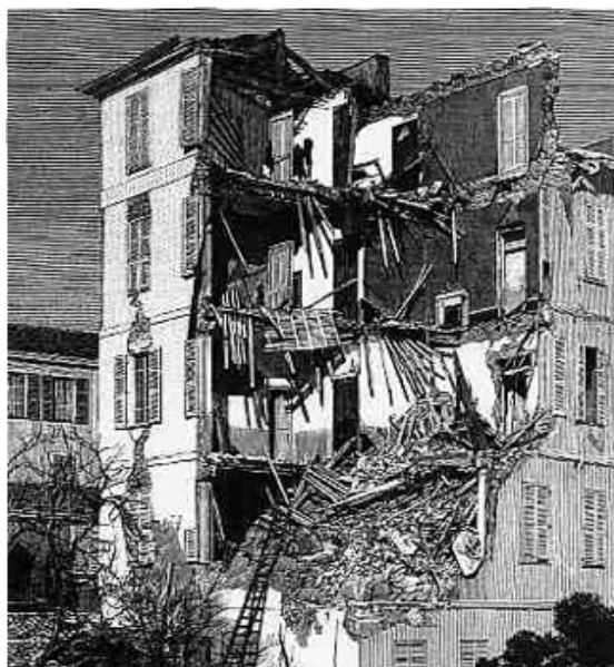
Figure 12 : Les effets du séisme de 1887 sur une construction du littoral méditerranéen
